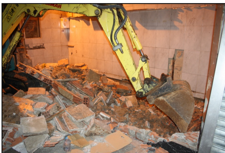
Fotografia 2. Enderroc de la parada 712-713-714
